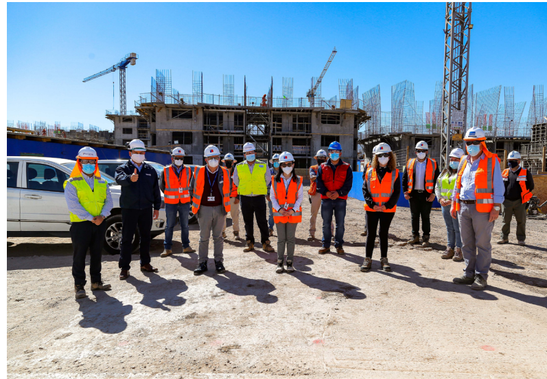
En las obras del proyecto habitacional “Cumbres El Palomar”, actividad en la que fue acompañada por la directiva local de la Cámara Chilena de la Construcción.
